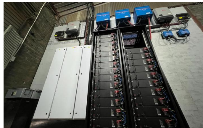
Off Grid system, SA 44.5 kWp, 120 kWh (2022)
